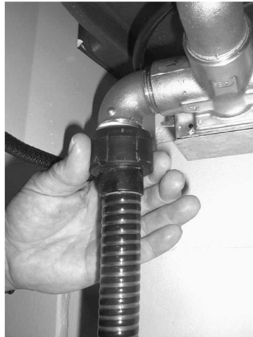
Abb. 4: Zuleitung anschließen
