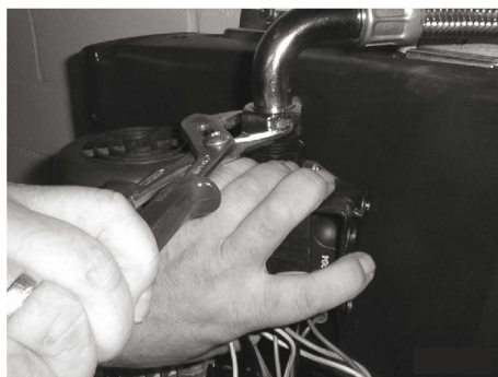
Abb. 27: Druckleitung lösen
