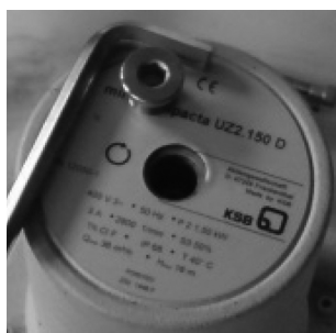
Abb. 15: Drehrichtung Pumpe
